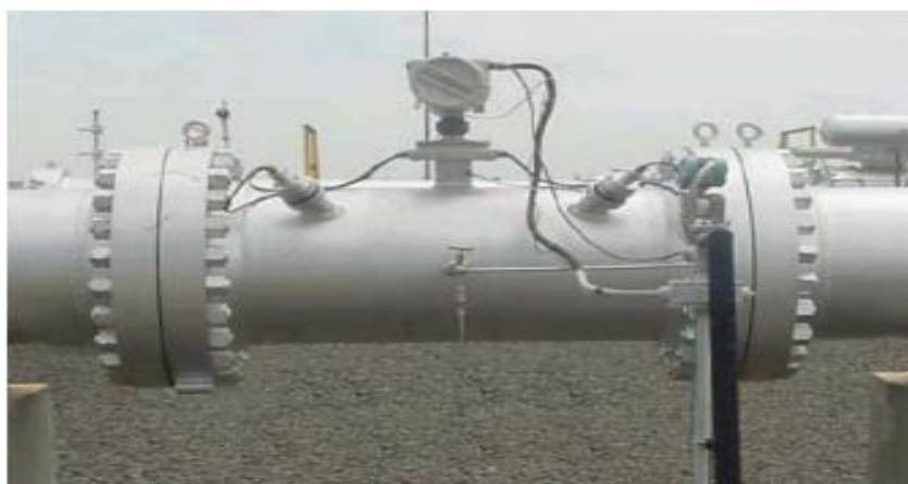
Figura 11 - Medidor ultrassônico intrusivo Fonte: Google Imagens
